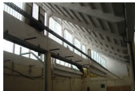
obstoječ objekt - znotraj - konstrukcija
