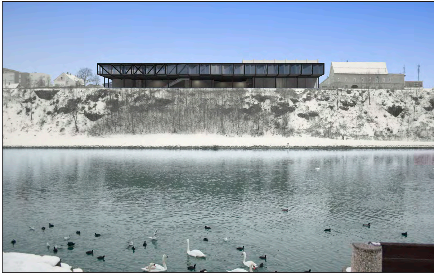
Pogled s sosednjega brega
