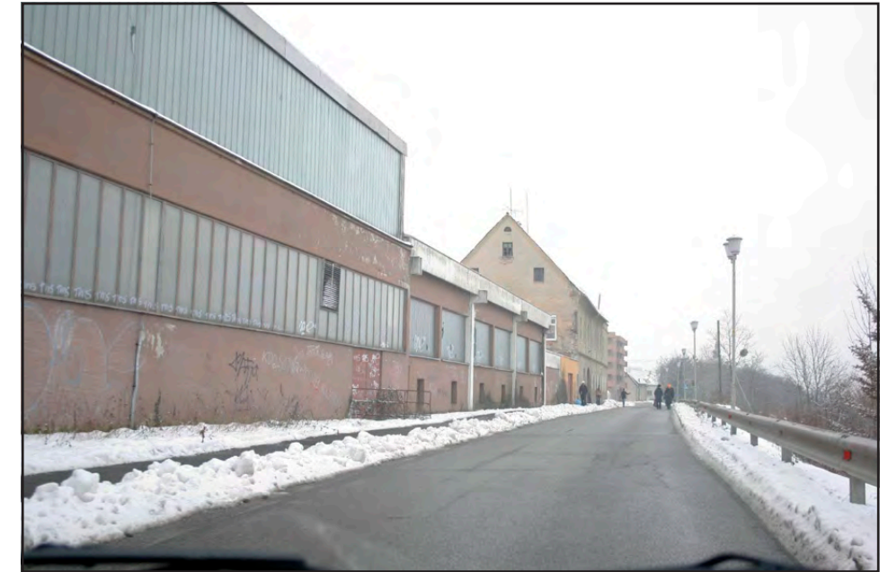
2 Pogled na obstoječ objekt Merinke vzdolž Ruške ceste
