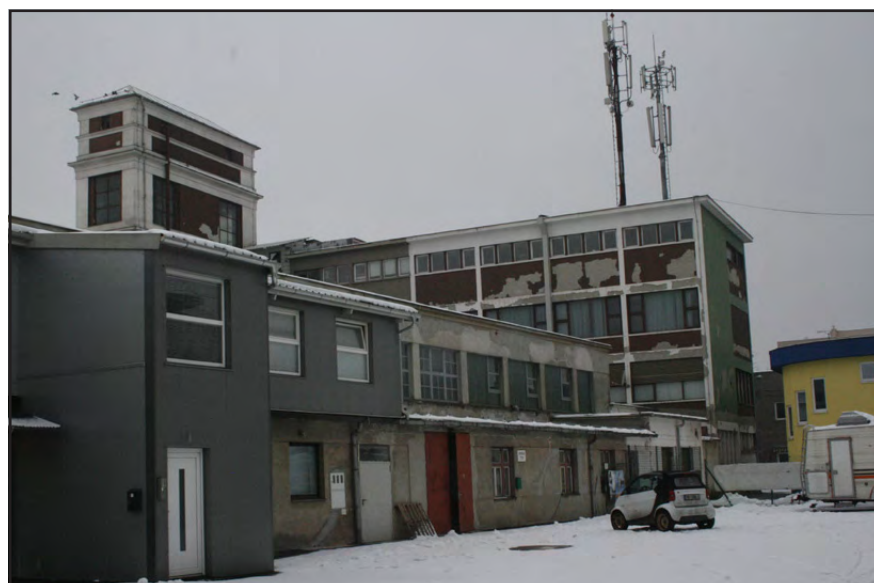
7 pogled na obstoječi objekt na Raičevi ulici
