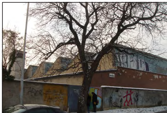
Obstoječa konstrukcija Merinke
