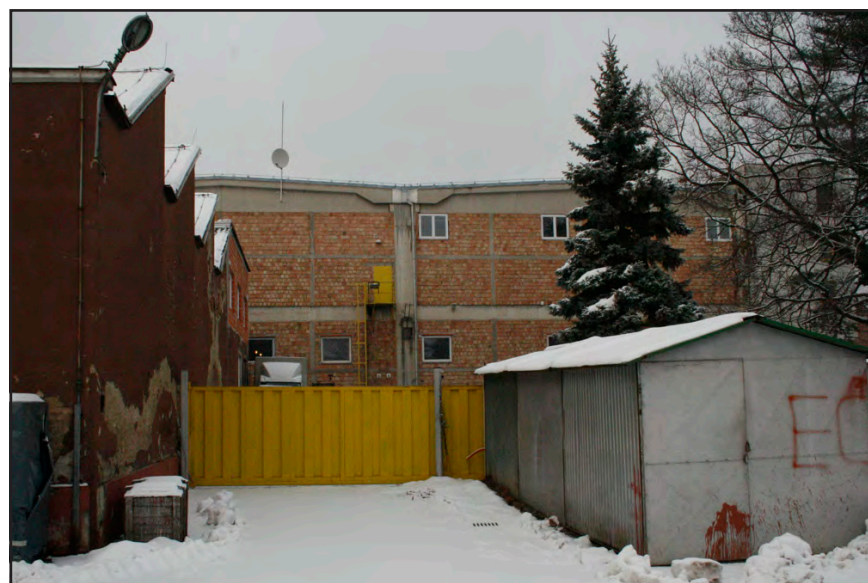
3 pogled na obstoječi objekt na robu tovarne Merinke
