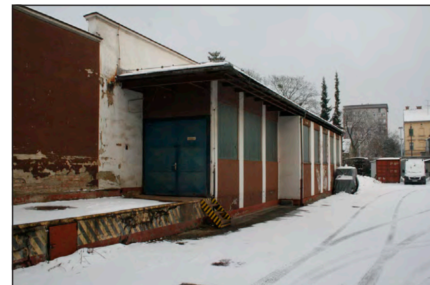
2 pogled na zadnjo fasado Merinke na območje 'B'
