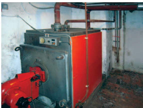
Slika 9: Stari oljni kotel
