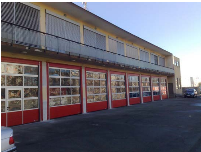
Zamenjana okna in vrata
