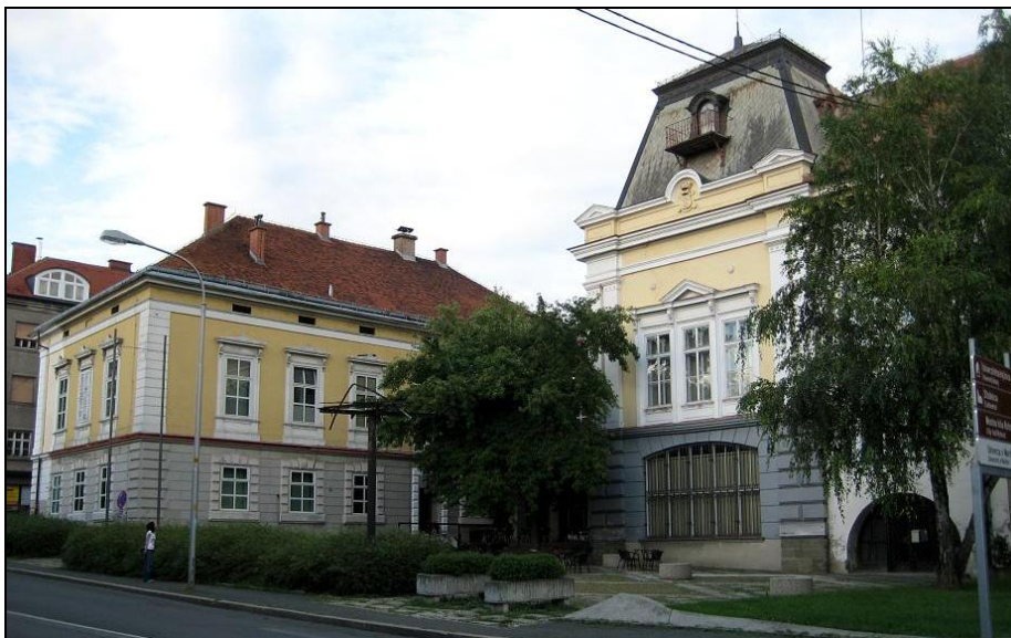
Slika 4: Obstoječ objekt UGM na Strossmayerjevi ulici 6 v Mariboru
