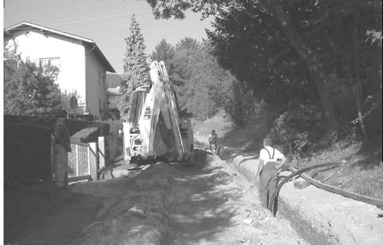
Izgradnja kanalizacije v Ulici Janka Semca
