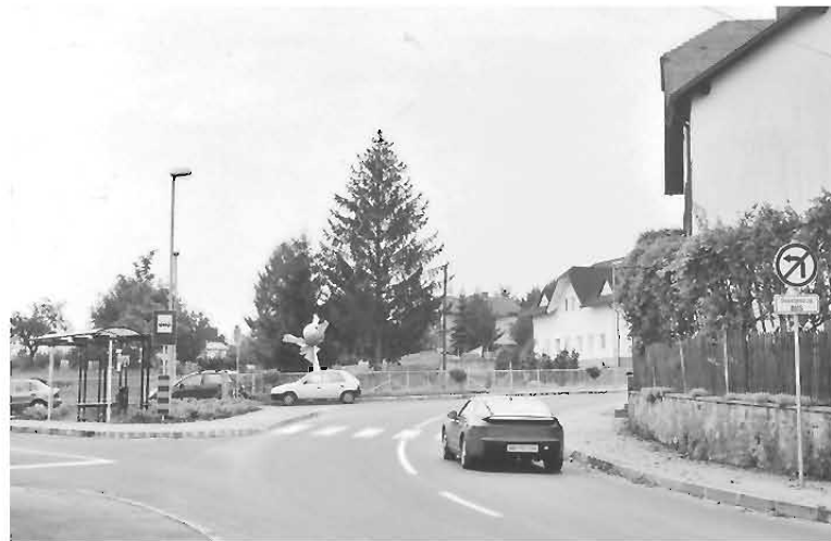
Pogled na del rekonstruirane Razvanjske ceste
