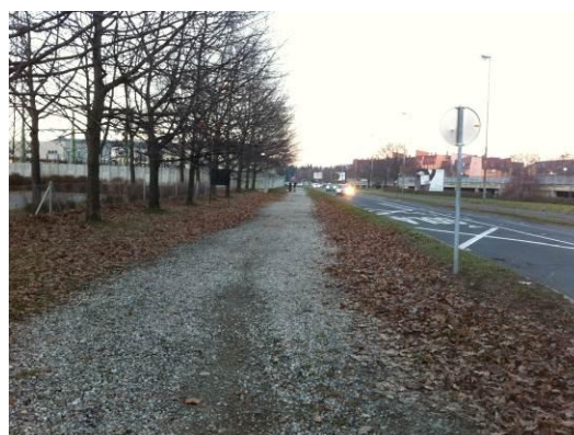
Slika 2.10: Obstoječe stanje UPO pri OŠ GŠ
