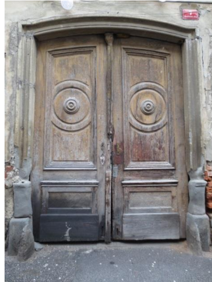
Vhodni portal v pritličju
