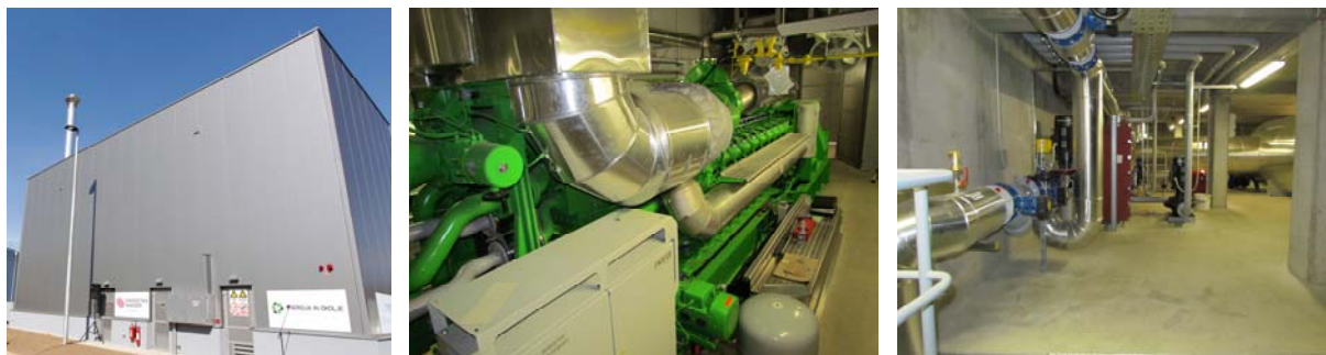
Slika 2: Objekt TOM III. – kogeneracijsko postrojenje
