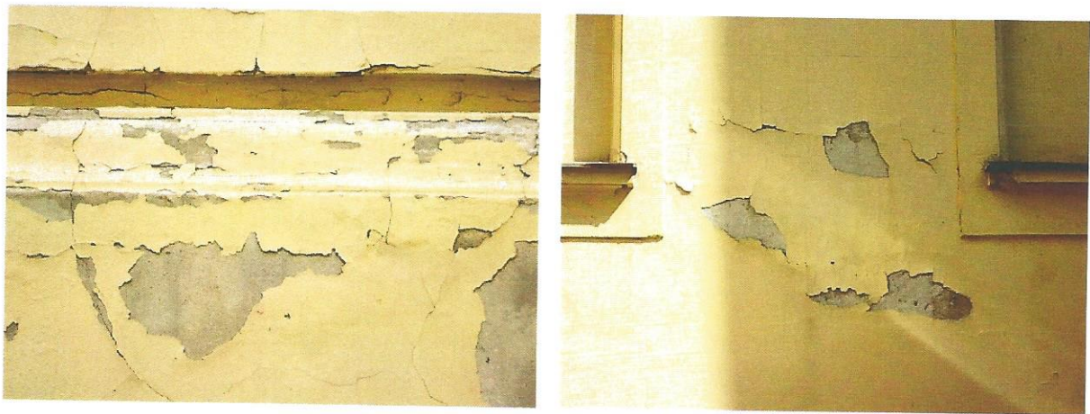
Slika 7: Obstoječe stanje južne fasade – 2. del
