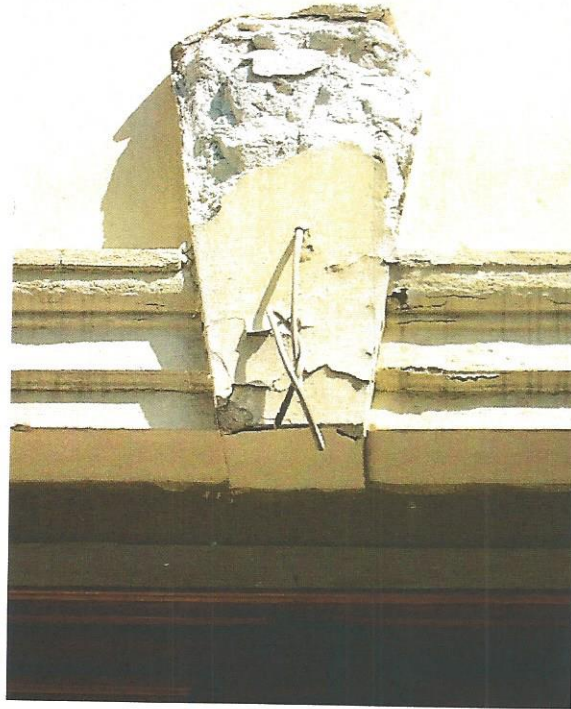
Slika 6: Obstoječe stanje južne fasade – 1. del
