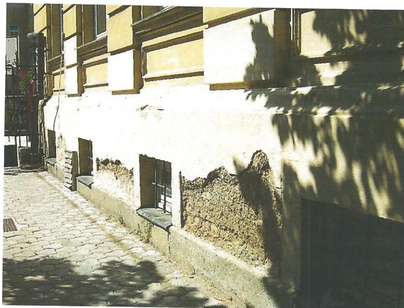
Slika 5: Obstoječe stanje zahodne fasade
