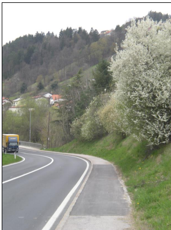
pričetek gradnje (zelenica pred mostom)
