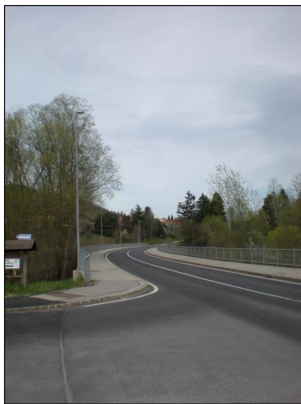
obešanje vodovodnega cevovoda na mostno konstrukcijo
