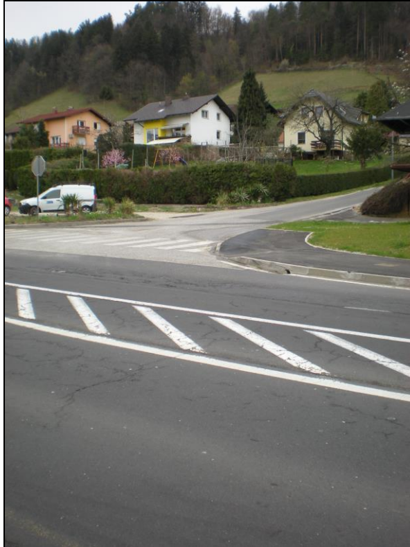
prečenje G1-1 na vozlišču V4 in navezava na obstoječi vodovodni cevovod
