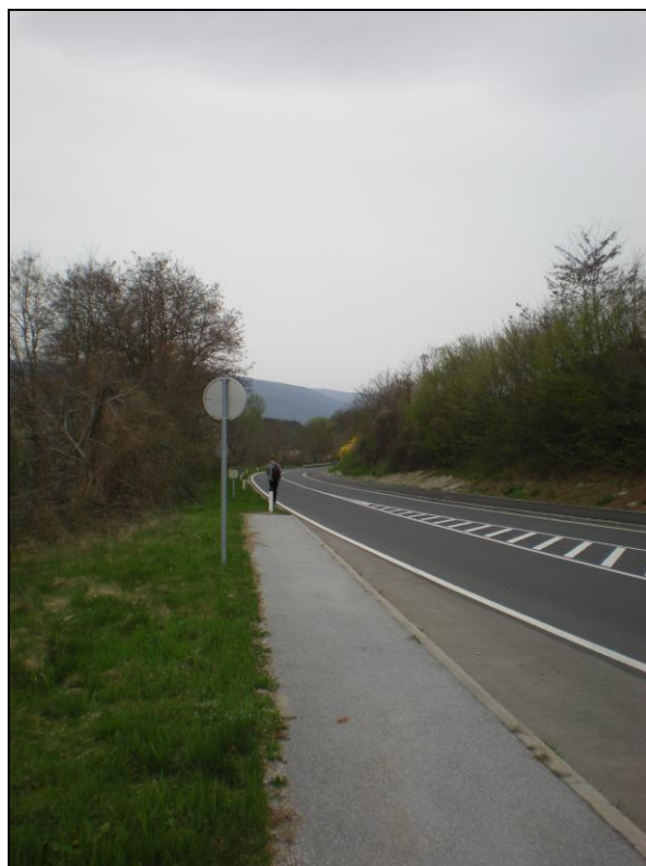
nadaljevanje trase cevovoda v zelenici na južni strani glavne ceste
