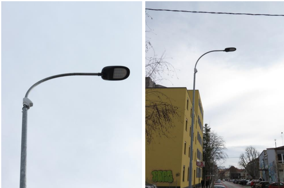
Slika 24: LED svetilka z vgrajenim senzorjem za radarsko zaznavanje prometa
