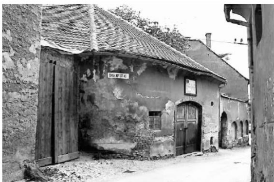
Slika 14: Objekt na Vojašniški ulici 14 nekoč in danes – ulična fasada
