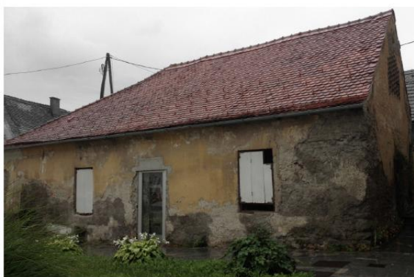
69 Vojašniška ulica 14; obstoječi pogled na dvoriščno fasado
