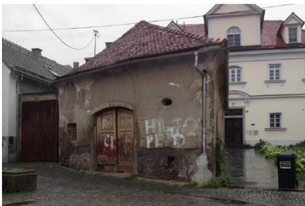
67 Vojašniška ulica 14; obstoječi prehod v dvorišče
