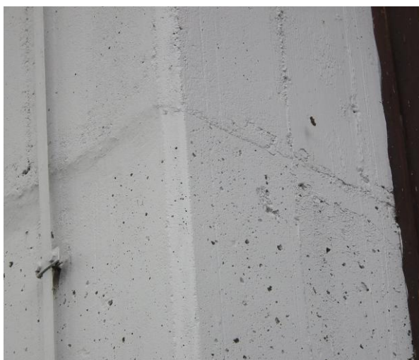
Slika 95: horizontalni razpoki v predelu spodnjega del. stika
