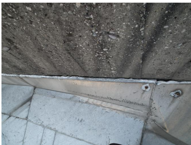
Slika 139: odstopanje obrobe med N11 in N12
