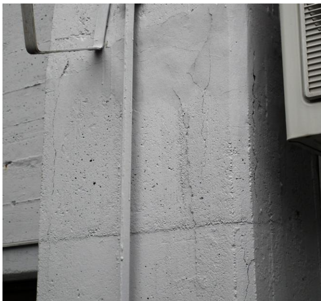
Slika 92: razpoke v robovih stebra S11
