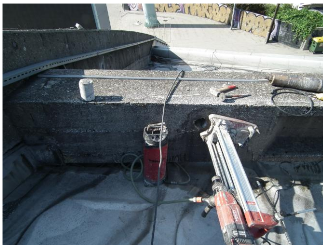
Slikas 8: prikaz pozicije sonde V2 v nosilcu N1
