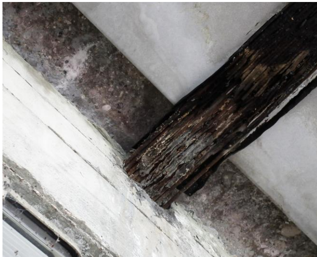
Slika 127: intenzivna korozij žic pramena nad stebrom S8
