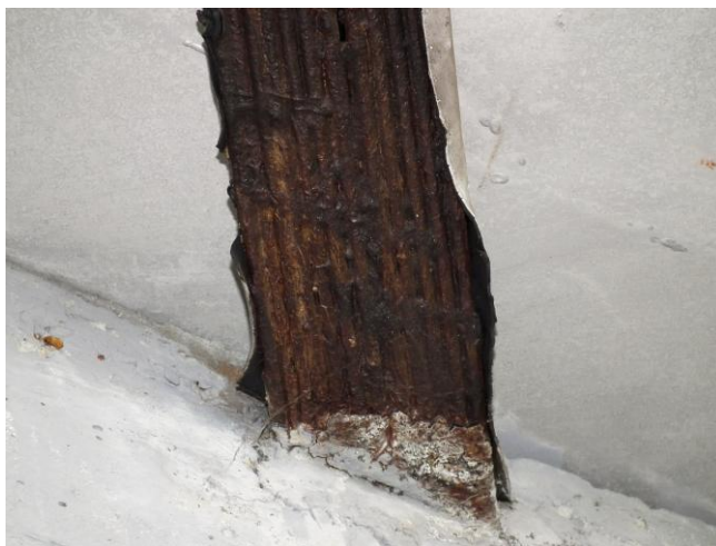
Slika 133: korozija žic pramena med S14 in S15
