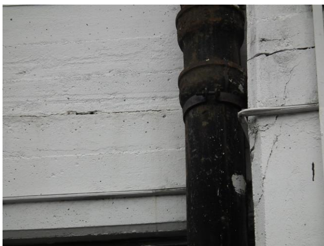
Slika 80: razpoka v stiku preklada – stena, levo od 5. stebra
