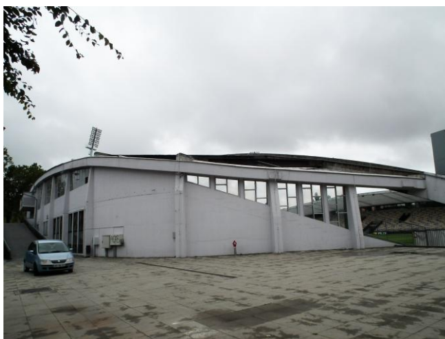
Slika 76: pogled na stebre, zunanji ločni nosilec in zidove
