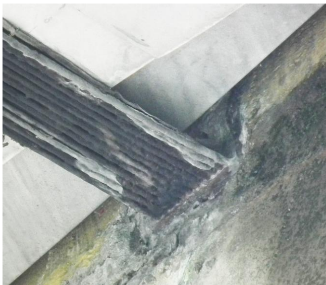
Slika 117: intenzivnejša korozija ži
