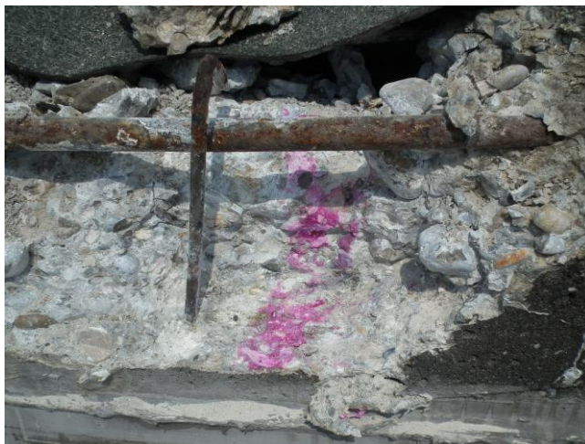
Slika 38: ugotavljanje globine karbonatizacije
