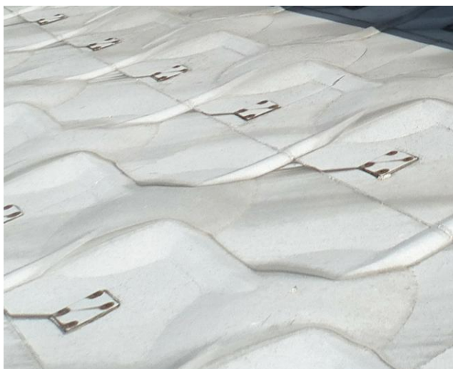
Slika 112: pritrjevanje pločevinaste kritine z zgornje strani strehe
