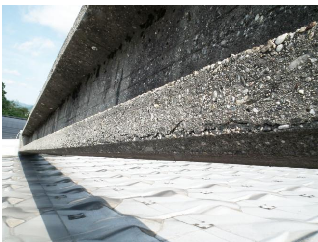
Slika 23: vzdolžna razpoka v spodnjem robu spodnje pasnice
