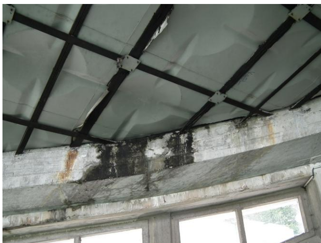
Slika 118: intenzivno zamakanje med 14.in 15. linijo pramen vpetih v zunanji nosilec
