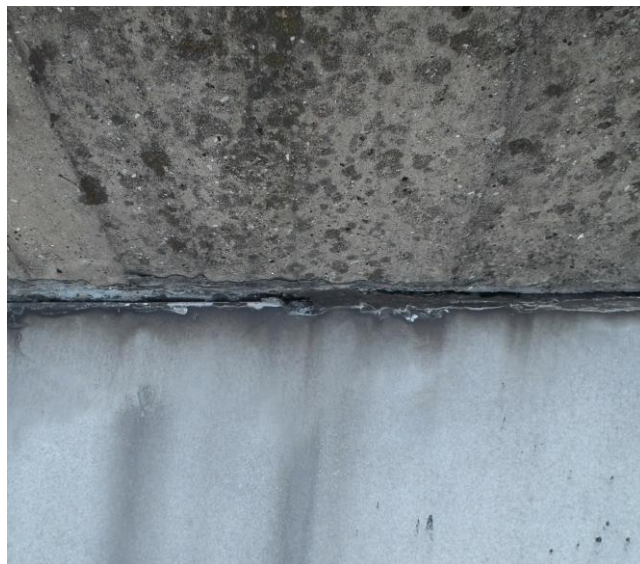
Slika 138: odstopanje obrobe med N7 in N8
