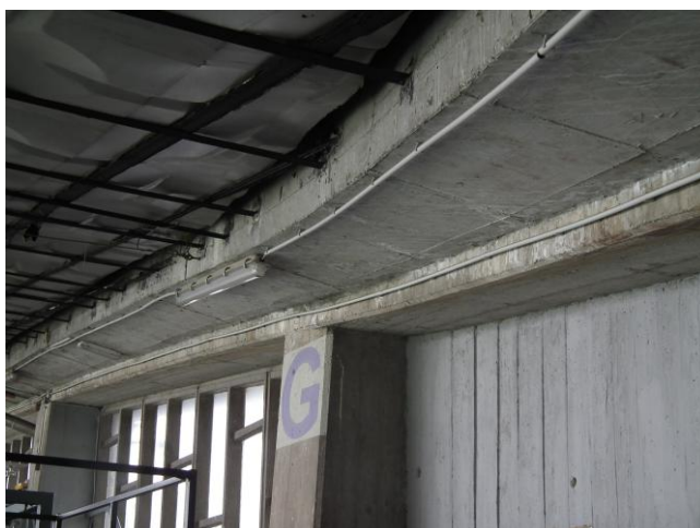
Slika 101: prikaz starega in dobetoniranega zunanjega nosilca
