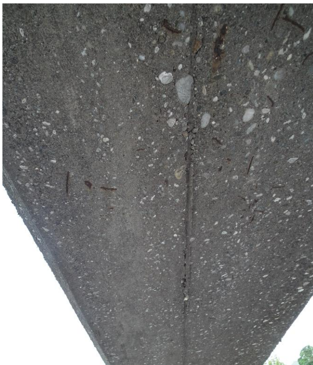
Slika 22: beton na spodnji strani spodnje pasnice – brez poškodb
