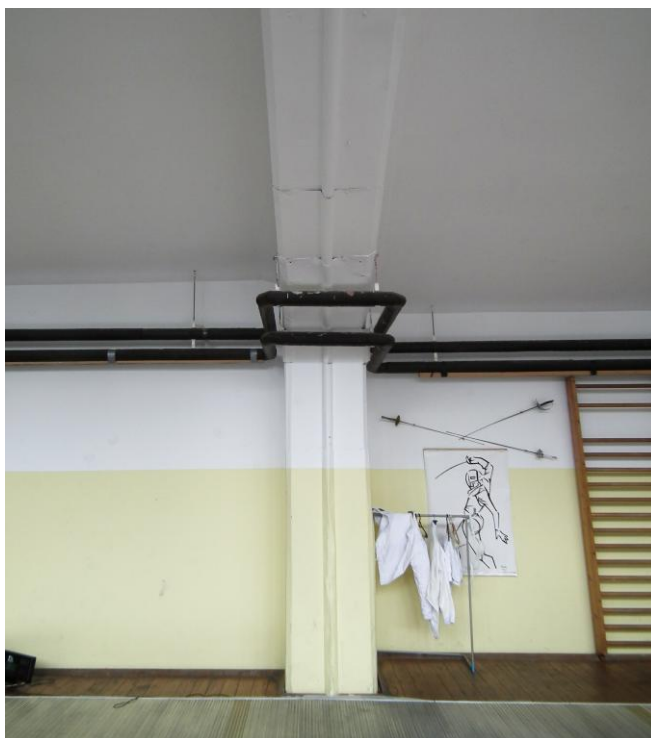
Slika 108: dilatacija v Telovadnici sever
