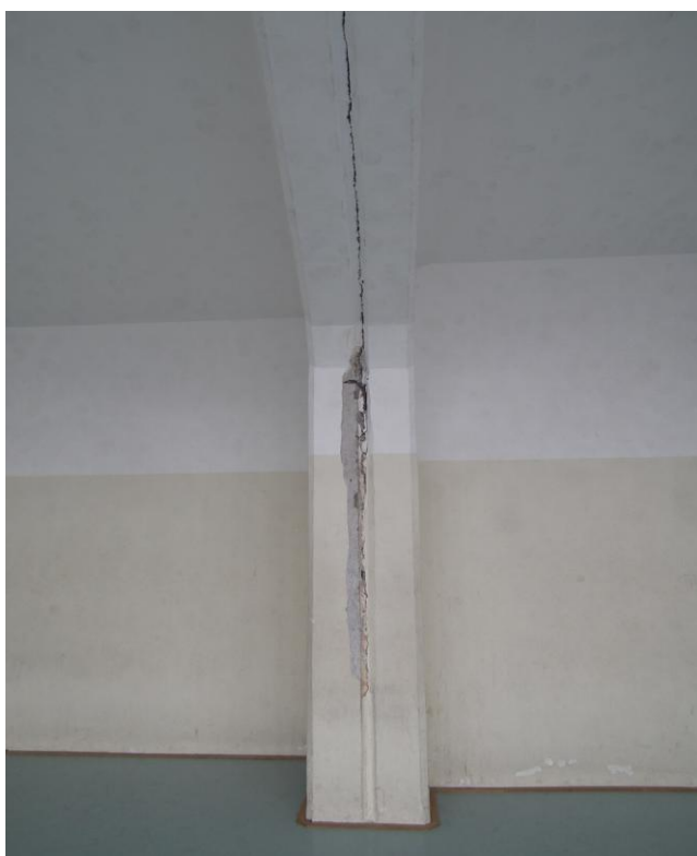
Slika 105: dilatacija v tribunskem nosilcu v liniji stebra S5
