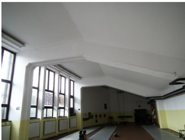
Slika 107: tribunski nosilci v predelu Telovadnice sever
