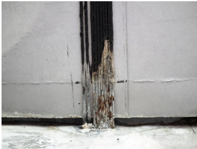
Slika 123: intenzivna korozija žic pramena nad S6
