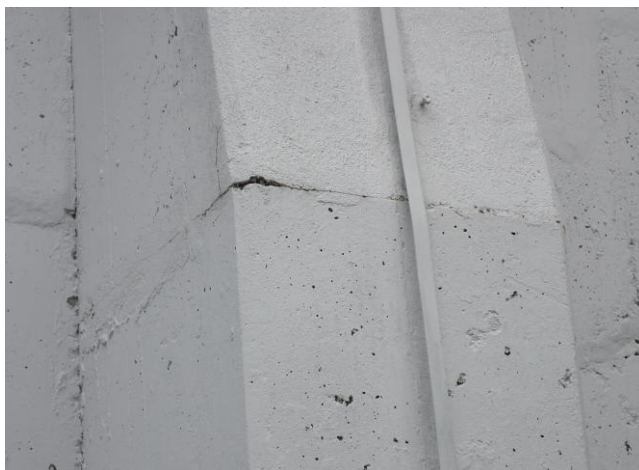
Slika 100: horizontalna razpoka v predelu del. stika
