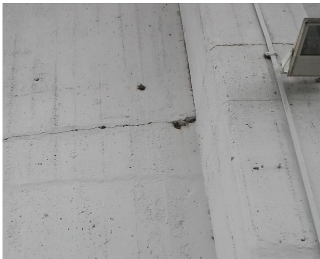
Slika 97: širša razpoka v stiku preklada – zid, levo od stebra S13
