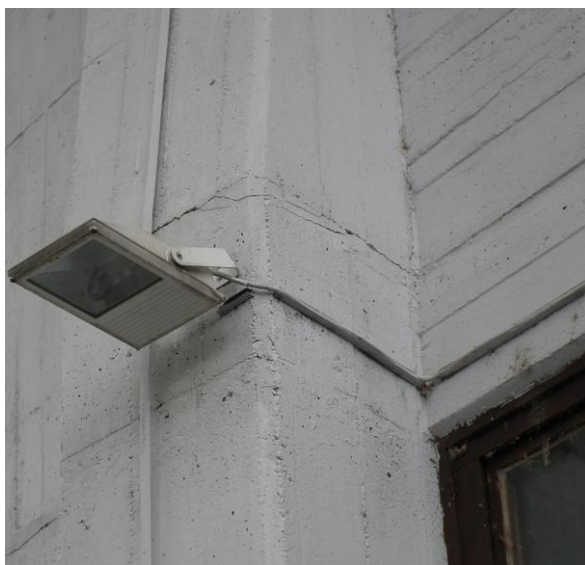
Slika 96: horizontalna razpoka v gornjem del. Stiku
