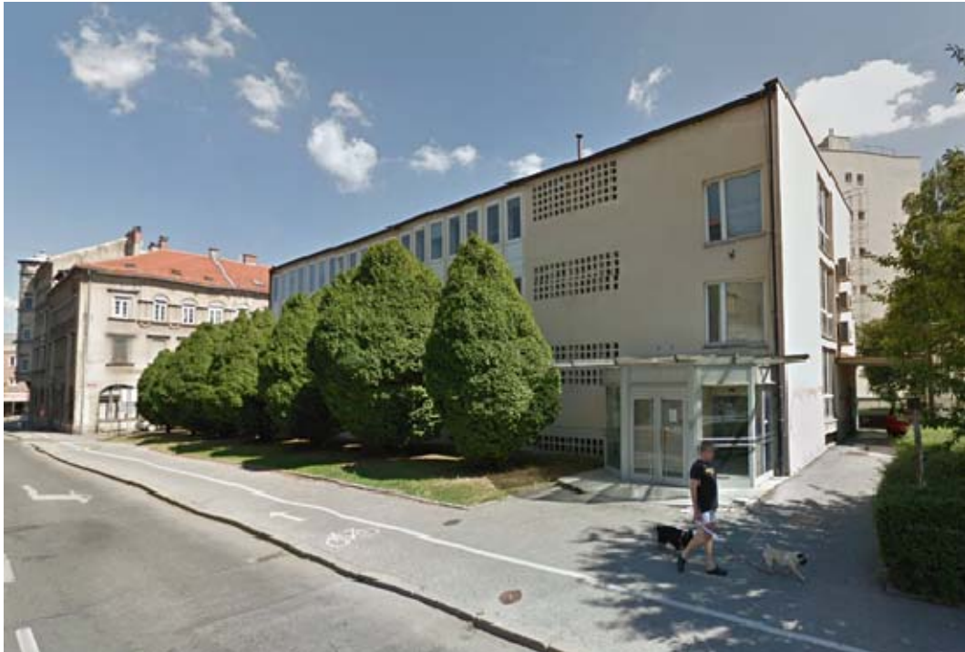
Slika 4: Pogled na obstoječo stavbo
