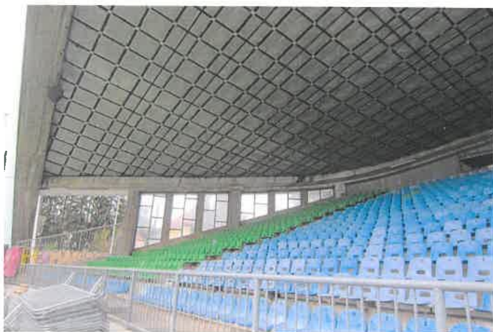
Slika 4: Tribuna s strešno konstrukcijo
