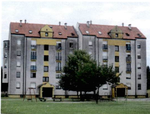
Stavba Engelsova ulica 42 - 44
