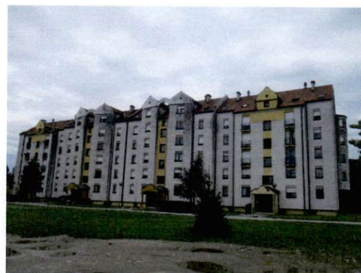
Stavba Engelsova ulica 46 - 52
