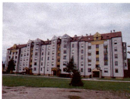
Stavba Engelsova ulica 46 - 52
