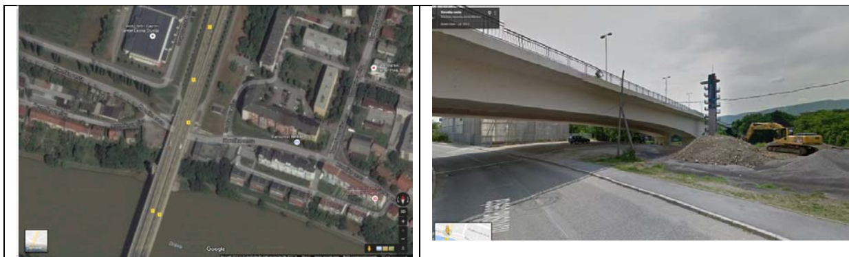
SLIKA 5: Pod Koroškim mostom, levi breg, stanje 2016
