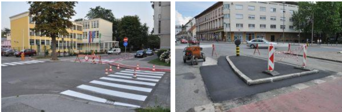
Slika 3: Vzdrževanje javnih prometnih površin in asfalterska dela (vir: https://www.nigrad.si/promet )
