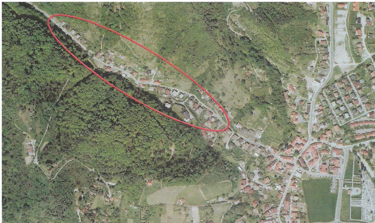
Slika 7: Lokacija predvidenih kanalov in cestišča (vir: DIIP za I. in II. fazo)
