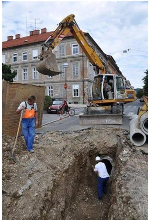
Slika 2: Izvedba objektov javne kanalizacije (vir: https://www.nigrad.si/kanalizacija )
