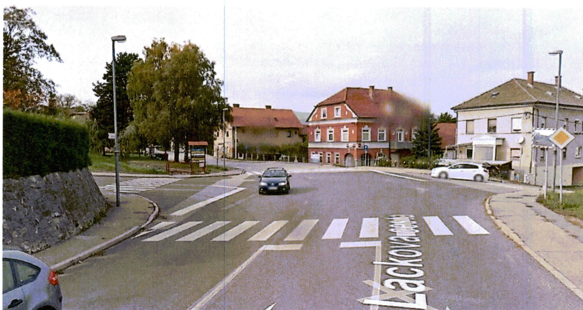
Slika 3: Konec posega v križišču Lackove ceste z Bežakovo ulico v Pekrah (vir: Google Street View)
