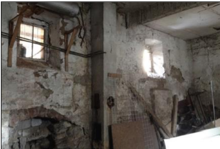
Slika 17: Obstoječi pogled v notranjost pritličja
