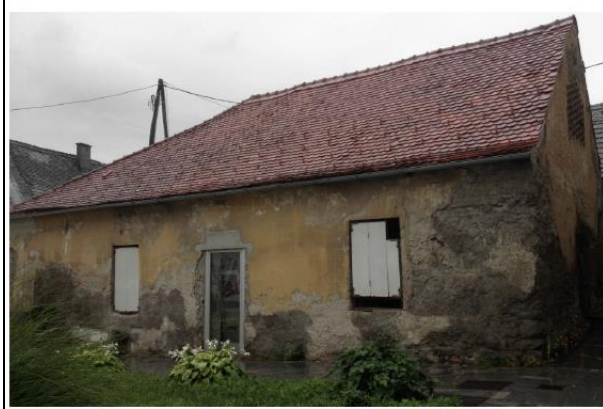
69 Vojašniška ulica 14; obstoječi pogled na dvoriščno fasado
