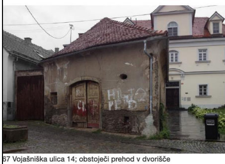
67 Vojašniška ulica 14; obstoječi prehod v dvorišče
