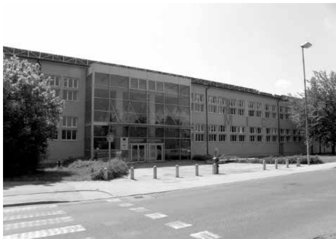
Pogled na objekt s severne strani
