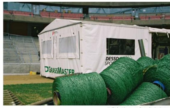
Slika 3: Hibridna trava – kombinacija naravne trave in trave iz umetnih vlaken
