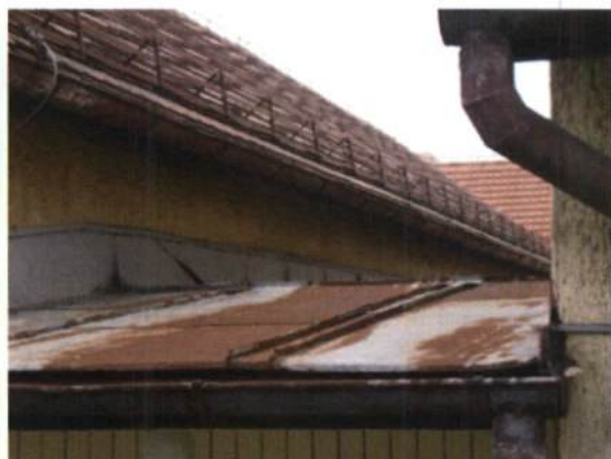
Slika 5: Fotografiji dotrajane strehe in žlebov objekta enote Ribiška.
