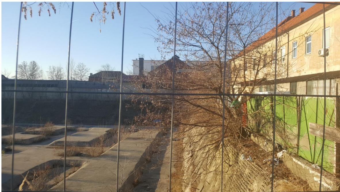
Slika 6: Pogled na obstoječe stanje, gradbeno jamo, proti jugu, skrajni zahodni del, ob Ruški cesti, vir: Urbis d.o.o.
