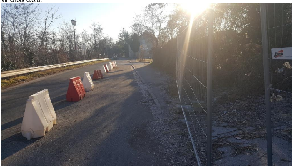
Slika 12: Pogled na obstoječe stanje Ruške ceste, pogled proti vzhodu, skrajni vzhodni del območja vir:Urbis d.o.o.
