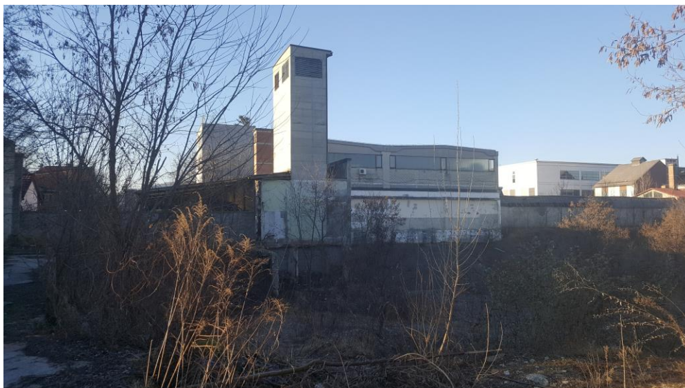
Slika 11: Pogled na obstoječe stanje, pogled proti jugu vir:Urbis d.o.o.
