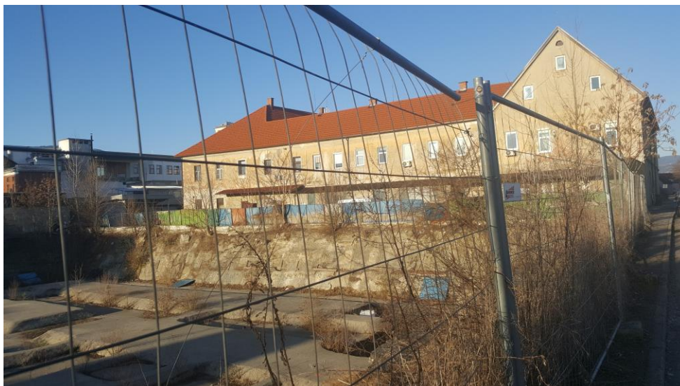
Slika 8: Pogled na obstoječe stanje, proti zahodu vir:Urbis d.o.o.
