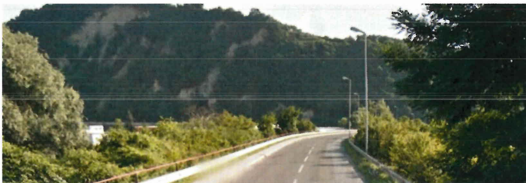
Slika 2: Pogled na lokacijo predvidenega priključka - levo
