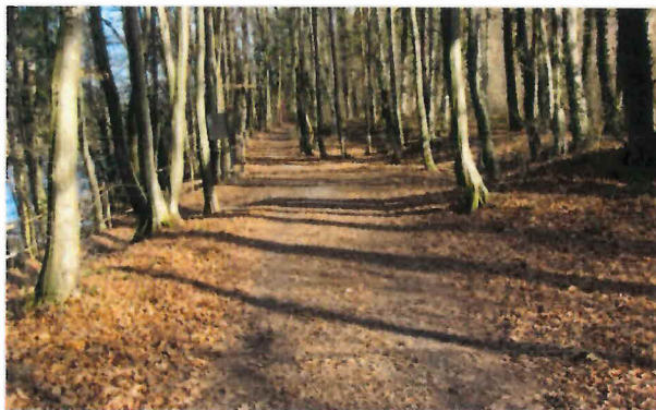
Slika 2: Obstoječa makadamska cesta od km 10+780 do km 11+325.
