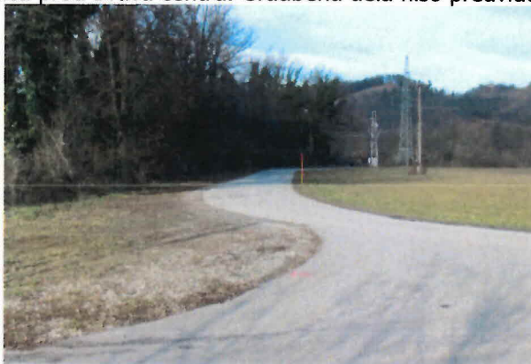
Slika 1: Obstoječa lokalna cesta ob potoku Blažovnica.
