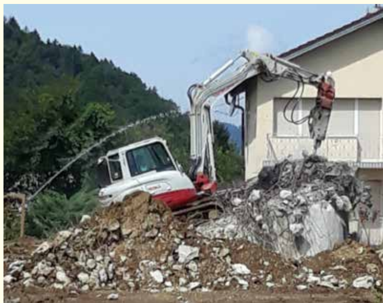
Težavno rušenje bunkerja v Robičevem zaselku
