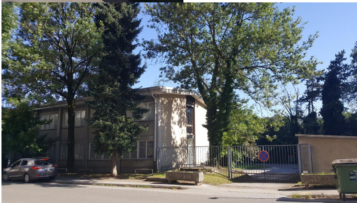
Slika 7,8: Obstoječe stanje stavb in ureditev, vir: Urbis d.o.o.
