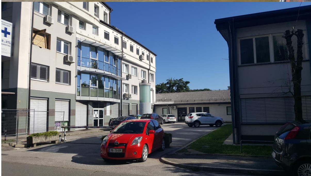
Slika 5,6: Obstoječe stanje stavb in ureditev, vir: Urbis d.o.o.
