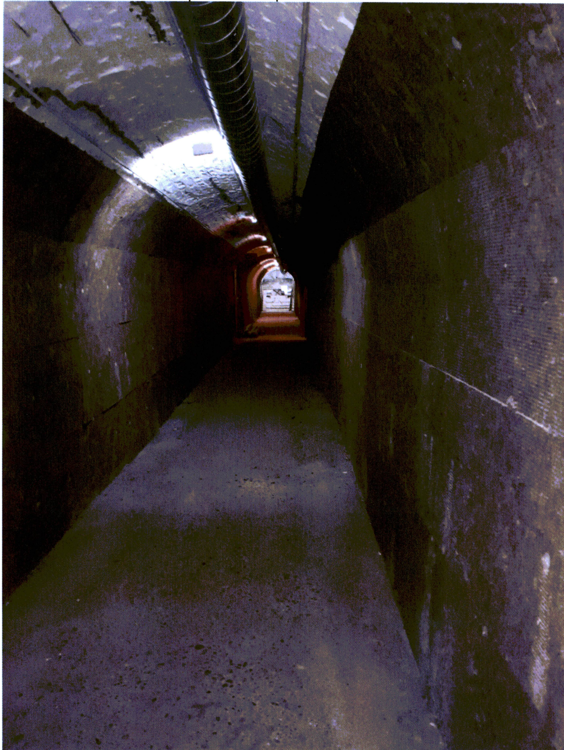
Slika 1: Hodnik zaklonišča po izvedbi usposobitvenih del
