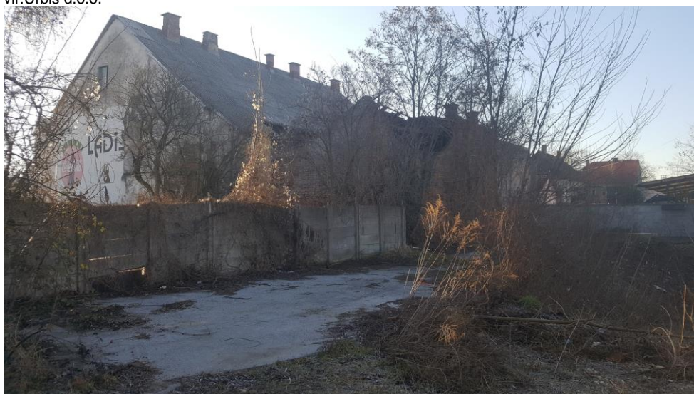
Slika 9: Pogled na obstoječe stanje, vzhodni del, obstoječi objekt izven območja urejanja vir:Urbis d.o.o.
