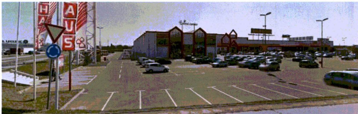
Pogled na območje z zahodne strani (vir: Google Street View , zajem slike jul. 2013)
