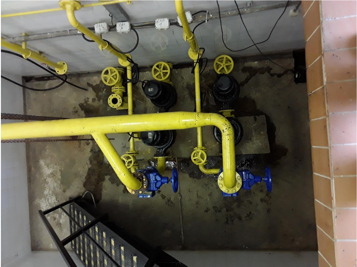
Slika 4 Dosedanji način prečrpavanja 4 x črpalke
