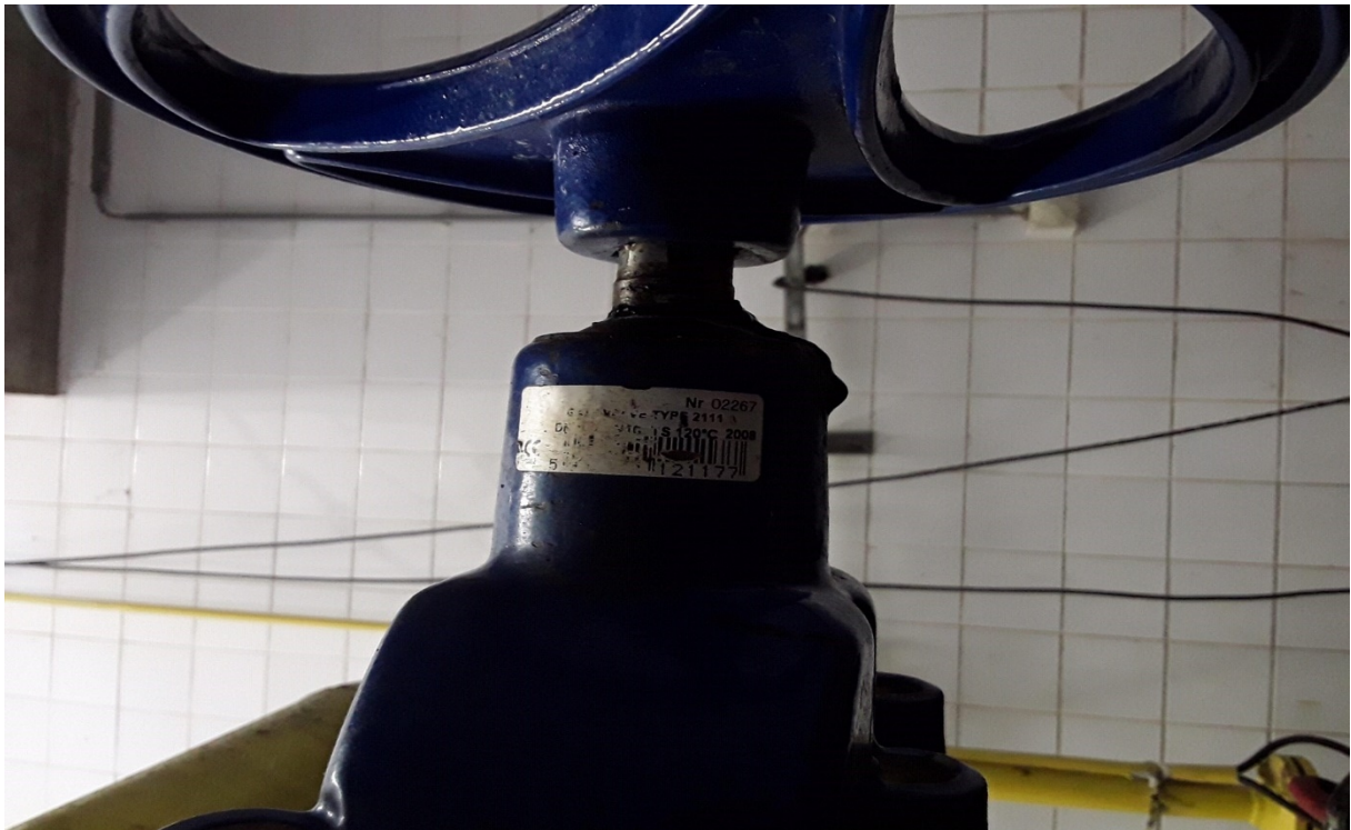
Slika 2 Dosedanji način prečrpavanja - zasun
