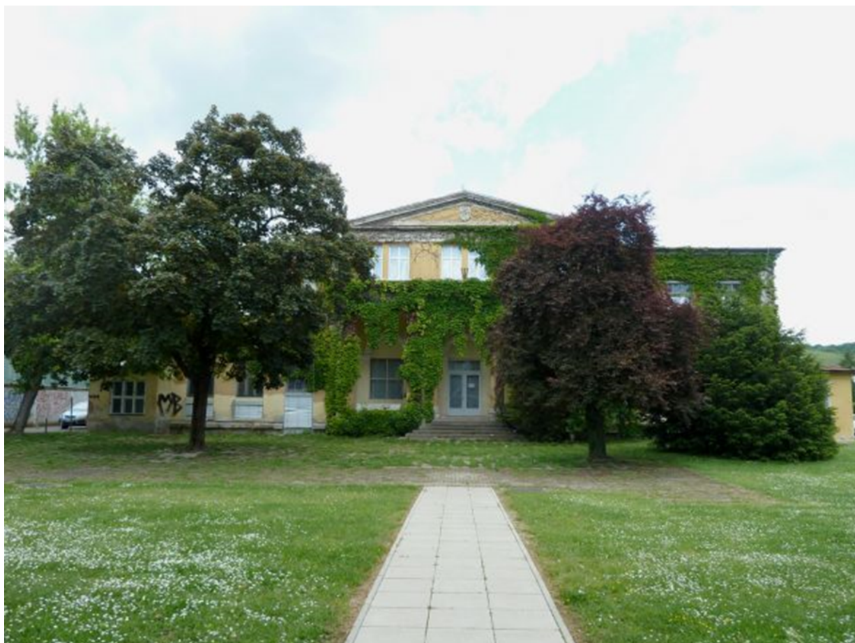
Slika 1: Slika zgradbe predvidene za rekonstrukcijo
