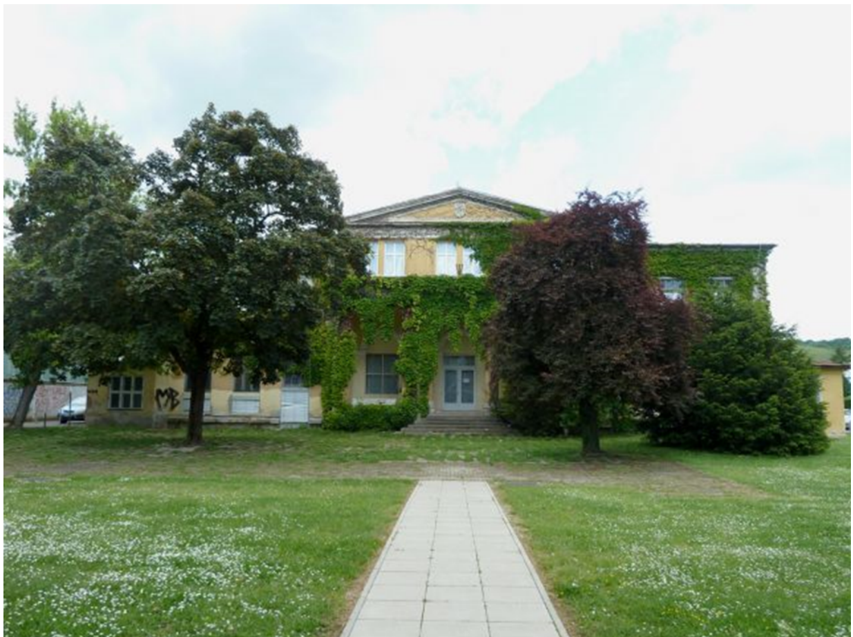
Slika 1: Slika zgradbe predvidene za rekonstrukcijo
