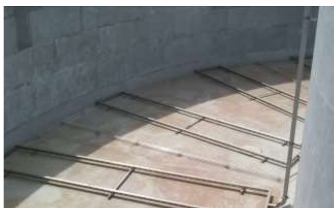
Slika 12.7: Sistem ozračevanja.
