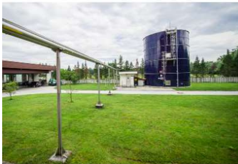
Slika 12.32: Čistilna naprava Domžale - plinohram 24 .
