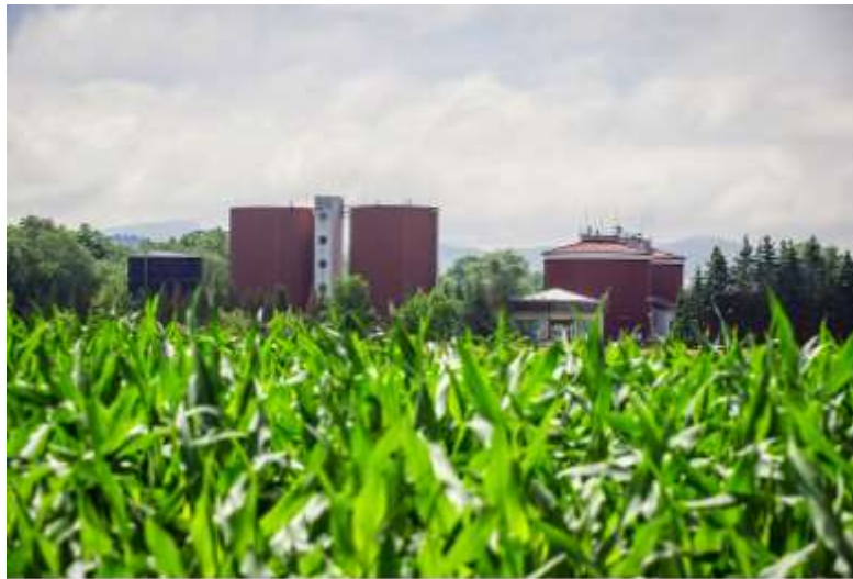
Slika 12.31: Čistilna naprava Domžale - gnilišča in plinohram 23 .
