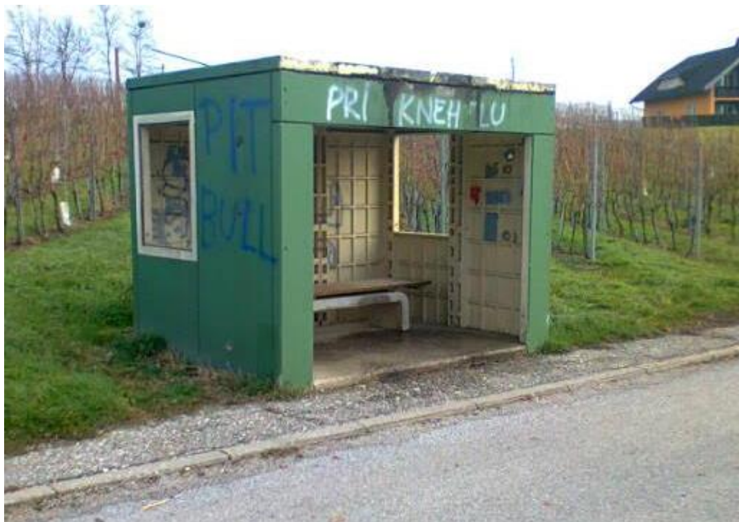
Slika 3: Primer nadstrešnice dotrajanega videza 3
