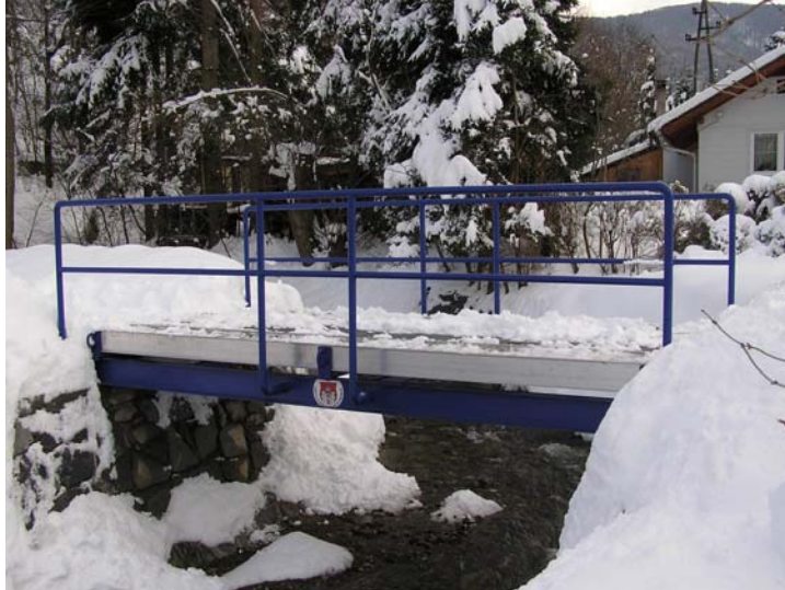
( postavitev začasnega objekta-montažni most na Blažovnici )
