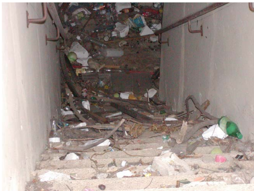
( vhod v zaklonišče - stanovanjski kare na Kardeljevi )
