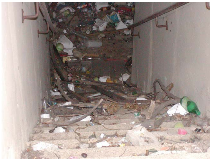
( vhod v zaklonišče - stanovanjski kare na Kardeljevi )
