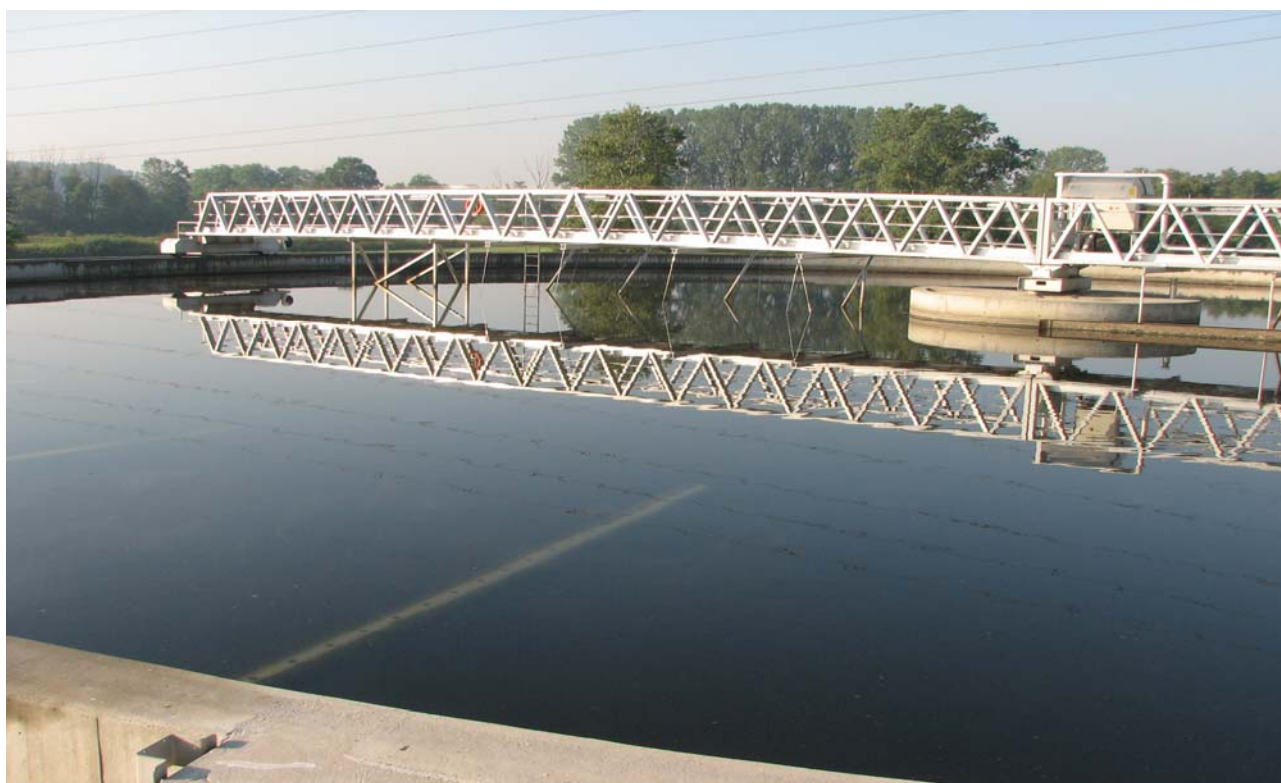
Slika 4.28.: CČN Maribor – prečiščena odpadna voda v naknadnem usedalniku, maj 2007 (Vir: Aquasystems d.o.o)
