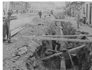
Intenzivna obnova vodovodnih cevovodov
